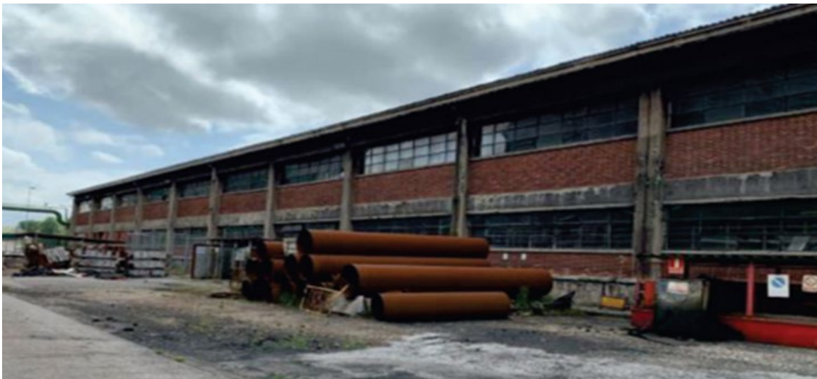
Foto Exterior zona Almacén.
